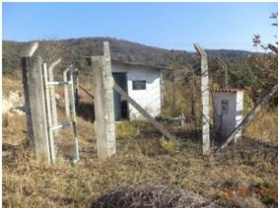
Figura 7.72 – Infraestrutura de captação do Sistema Grão Mogol
