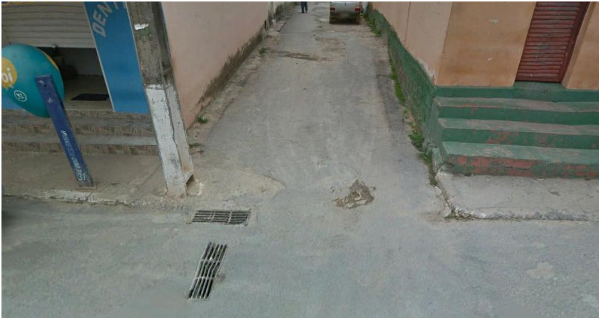
Figura 7.109 – Grelha na sede municipal
