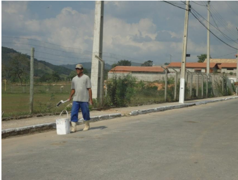
Figura 7.95 – Pintura de guias e postes
