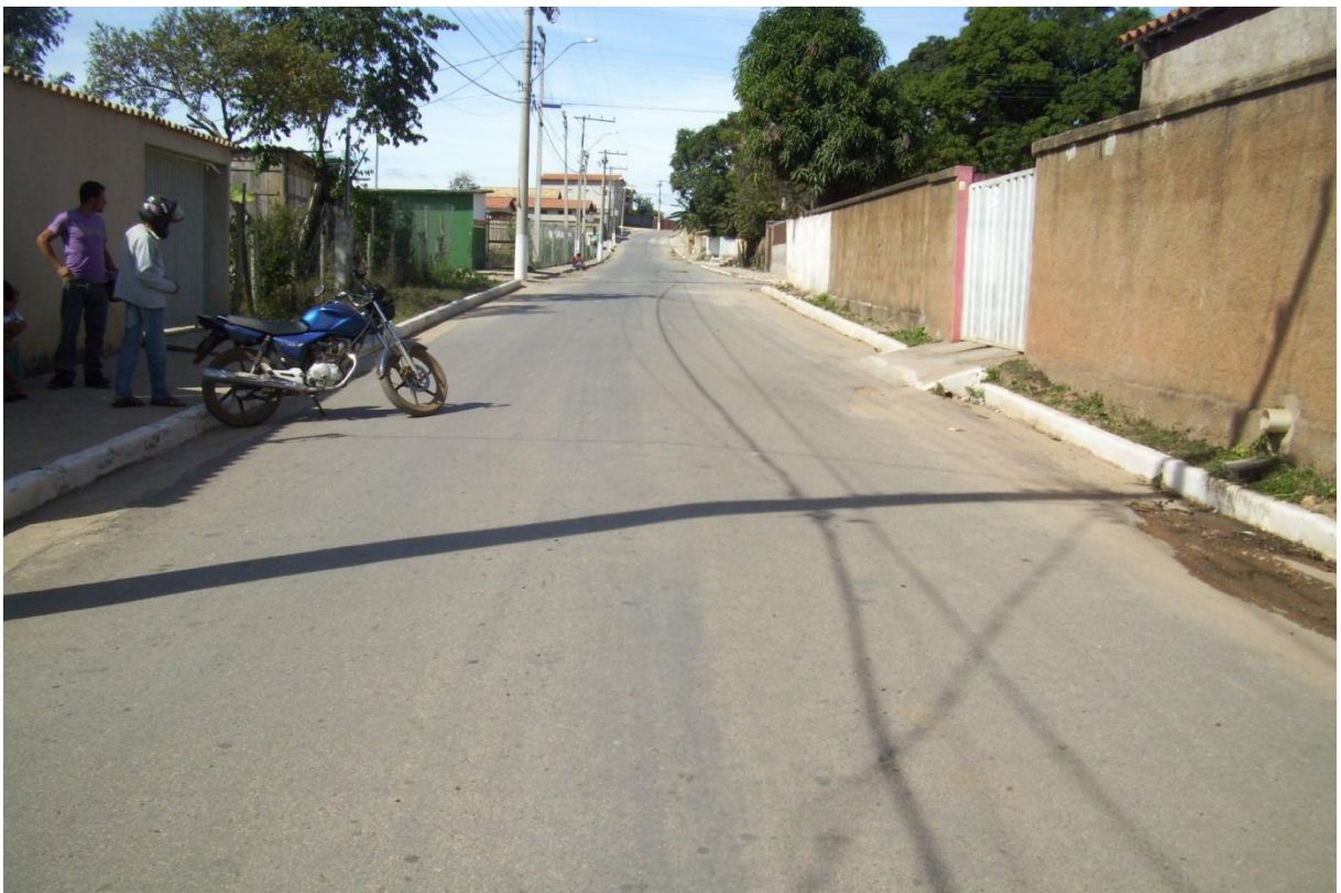
Figura 7.110 – Sarjetas na sede municipal
