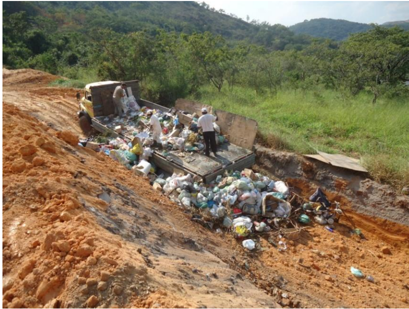
Figura 7.99 – Disposição de resíduos em vala do lixão municipal
