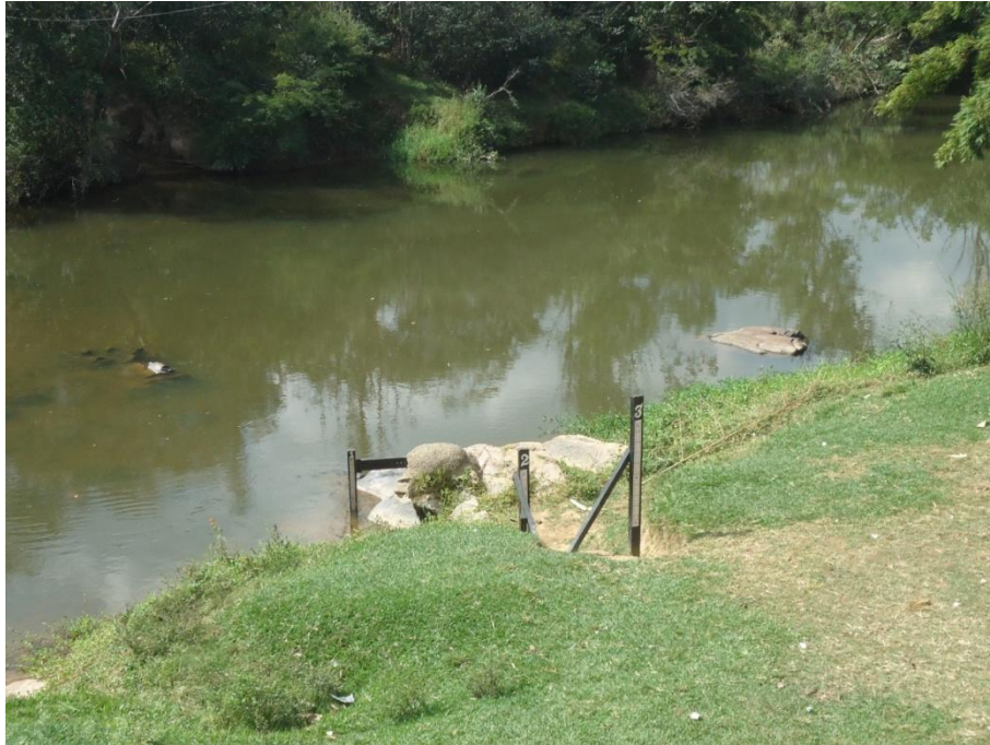
Figura 7.23 – Réguas linimétricas para monitoramento das vazões do Rio Taquaraçu na sede urbana
