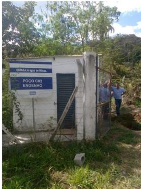
Figura 7.64 – Poço C02 do Sistema Engenho
