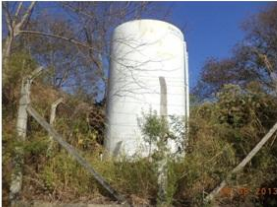
Figura 7.73 – Reservatório de água do Sistema Grão Mogol
