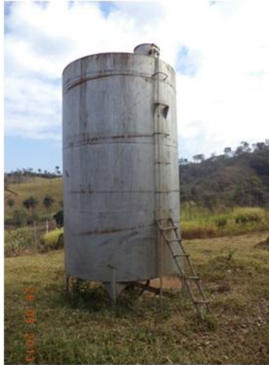
Figura 7.69 – Reservatório de água de Casas Velhas
