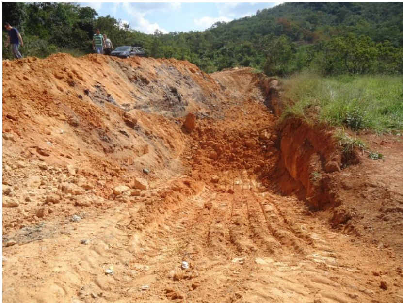
Figura 7.98 – Vala aberta para a disposição dos resíduos
