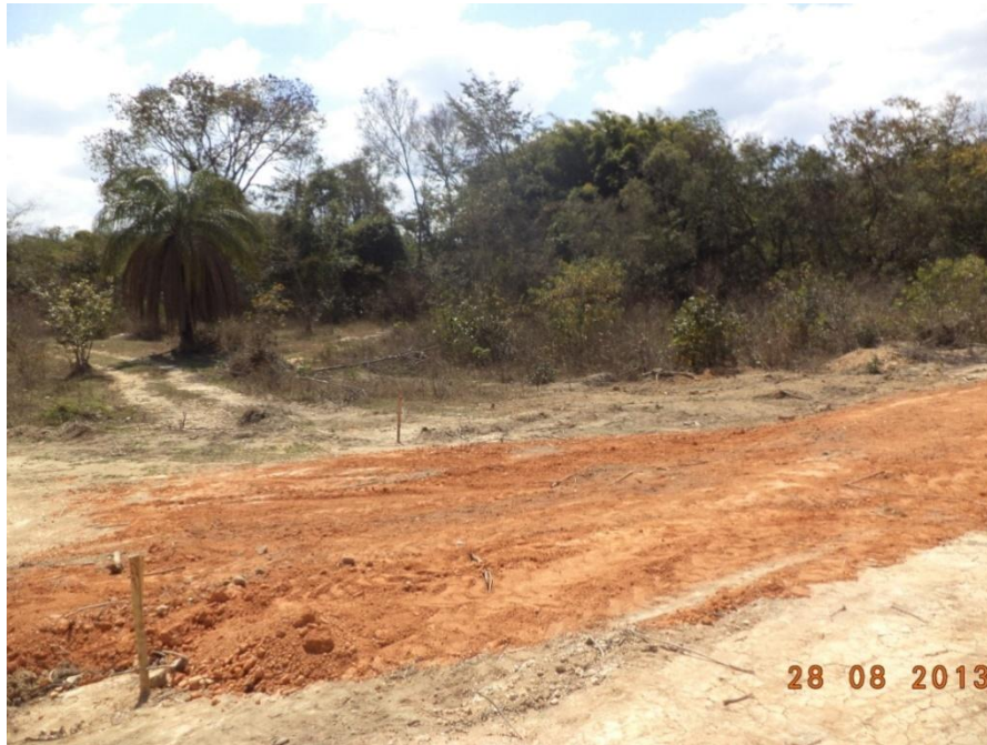
Figura 7.83 – Área de implantação da futura ETE de Taquaraçu de Minas
