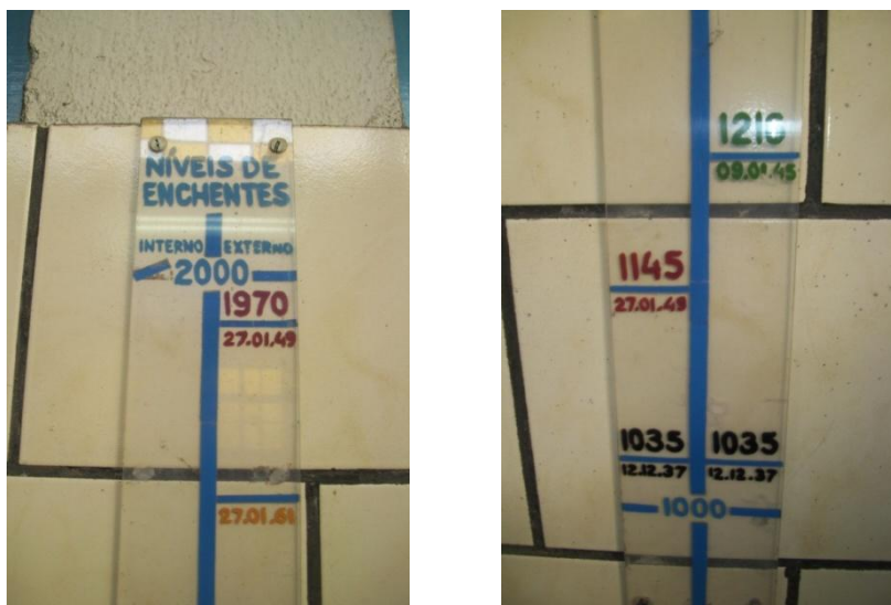
Figura 7.25 – Níveis de medição de vazões dentro das dependências da usina da Arcelormittal
